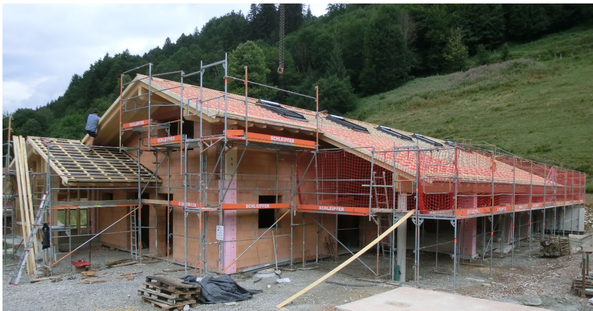
Rohbau unsers neuen Kindergartens
